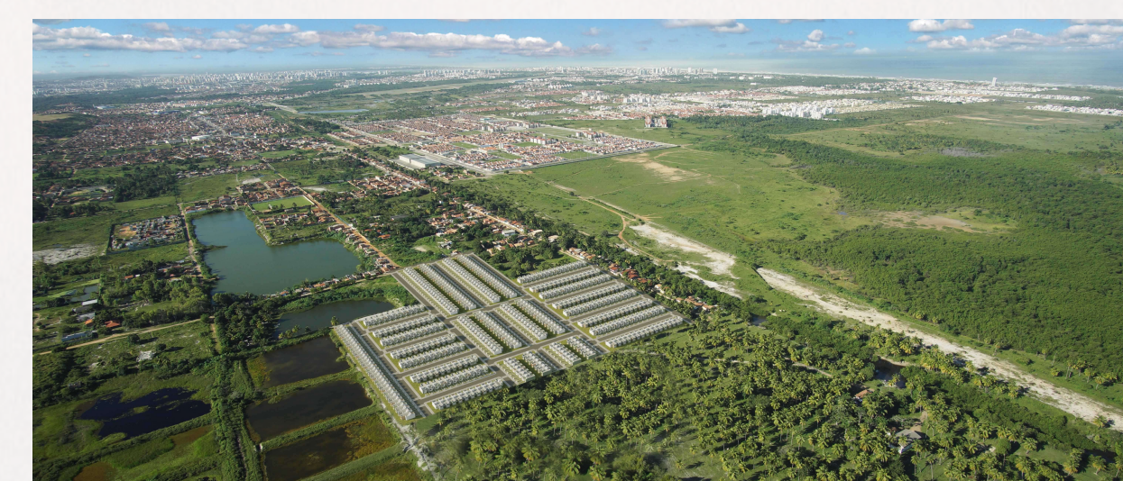
Figura 6: Empreendimento Horto Santa Maria (Faixa 1.5) em Aracaju com assentamentos precários à sua frente e vazios urbanos ao fundo. Fonte: GL Construtora.
